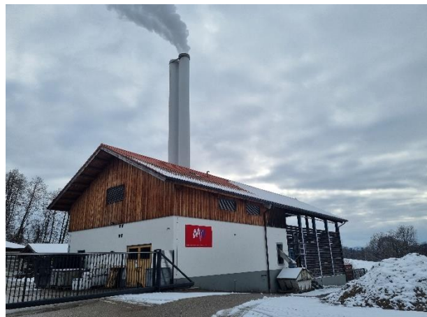
Heizwerk in Bad Endorf, Bild: Marktverwaltung Bad Endorf
