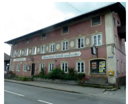
Leerstand / Schlechter Zustand, Bahnhofstr.
