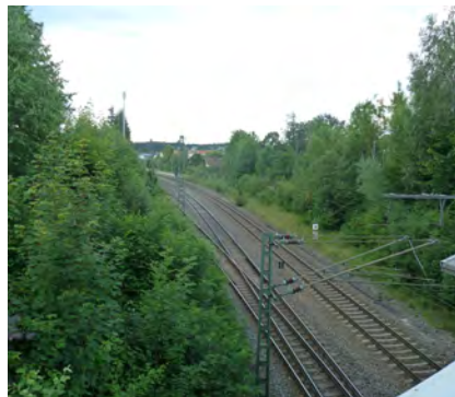
Räumliche Zäsur Bahnleise
