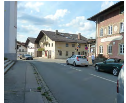
Schlechter Gebäudezustand Kirchplatz
