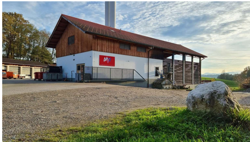
Abbildung 7: Holzhackschnitzelheizwerk in Bad Endorf © AMMELBURGER
