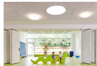
Beleuchtung: runde Aufbauleuchte (EG)
