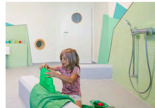
Referenzbild, Dusche mit Sitzrand, gefliest, Tiefe ca. 30cm, h=40cm, abgerundete Ecken und Kanten
