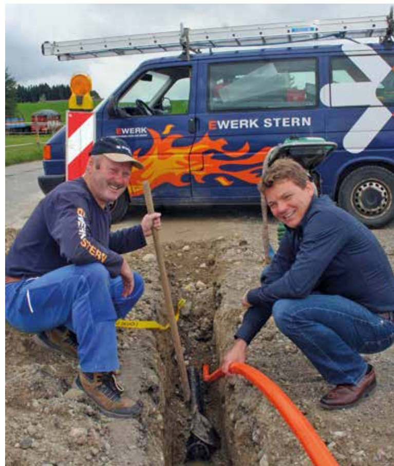
Von links: Manfred Riedel und Dr. Andreas Stern Verlegung des Glasfasernetzes
