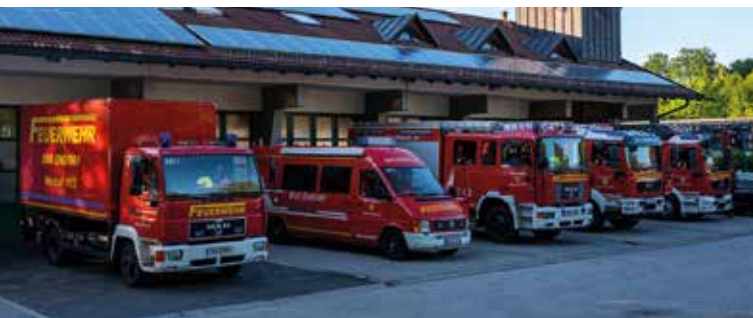
Feuerwehr Bad Endorf, Landinger Straße
