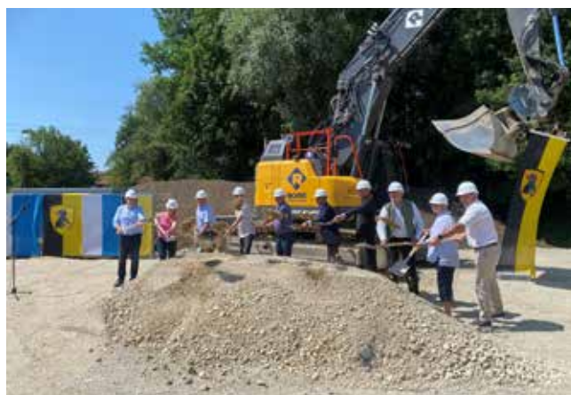
Spatenstich „neue“ Grund- und Mittelschule
