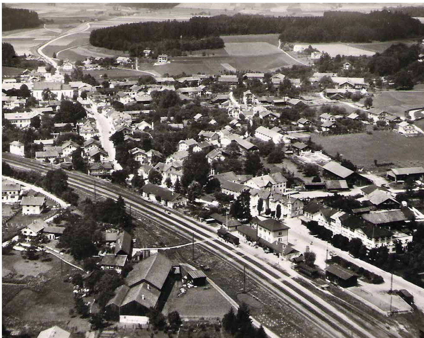
Bad Endorf - in Blickrichtung nach Norden / Halfing. Im Vordergrund der Bahnhof mit großen Lagerflächen.
