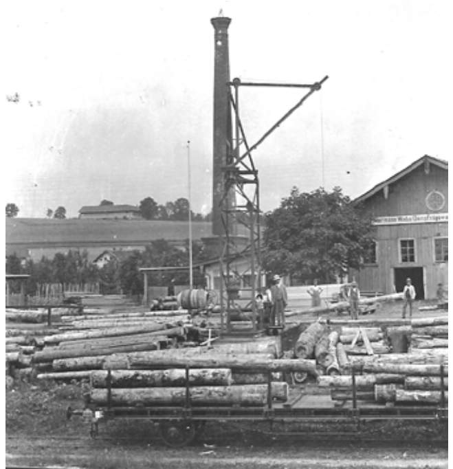
Sägewerk Wiebel mit Kran und Backsteinschornstein sowie eigenem Bahngleis.
